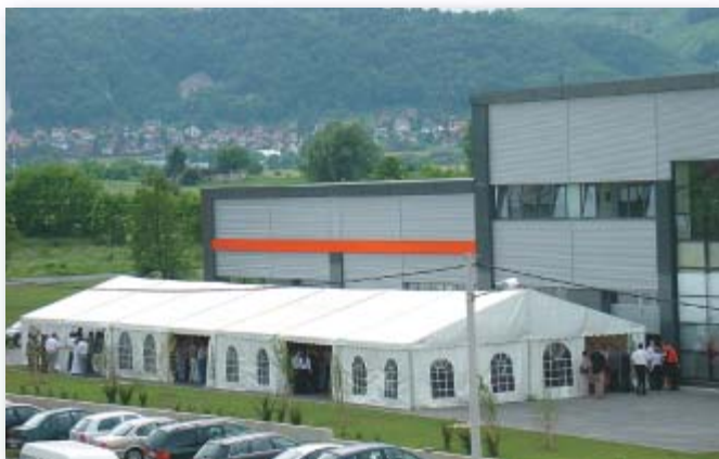
Pogled na šator koji je postavljen uz novi objekt
